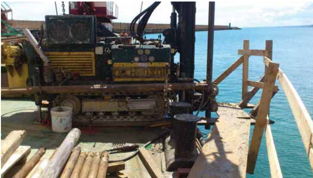
Foto 01 - Posizionamento a +2.0 metri dal l.m.m.
