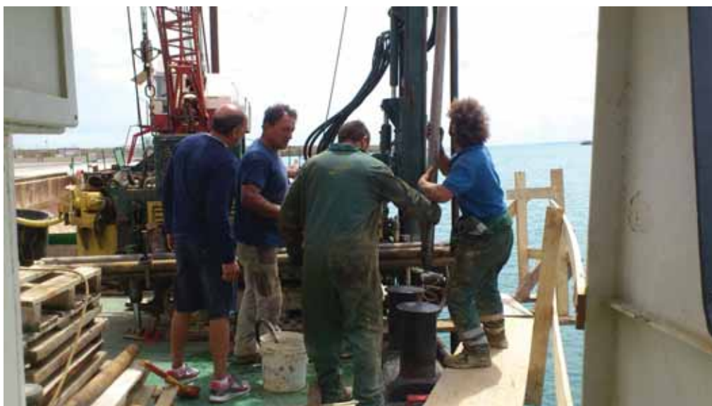
Foto 03 - Fasi di campionamento a carotaggio continuo con recupero di carota
