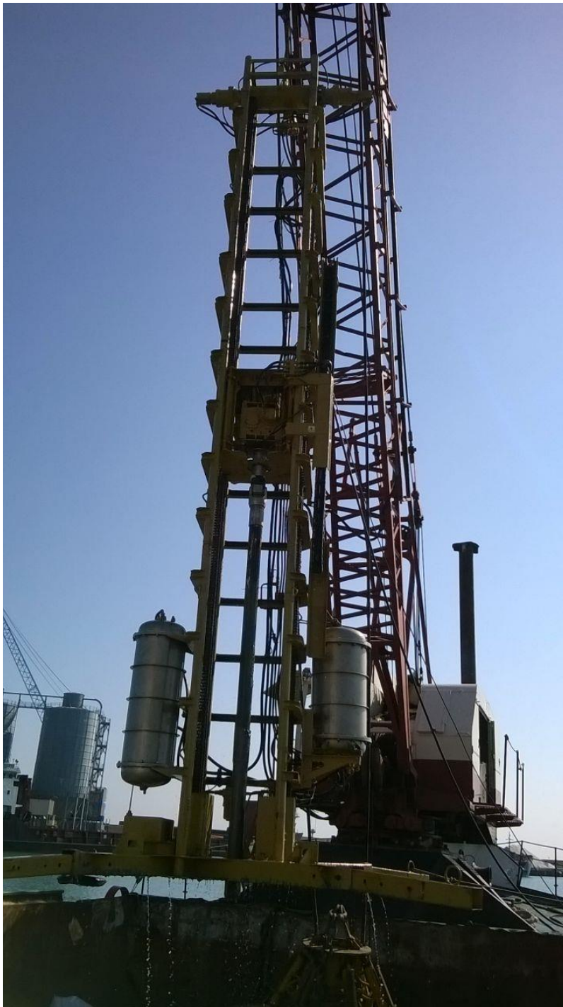
Foto n. 3: Vibrocarotiere utilizzato, della ditta GEOPOLARIS di Livorno, imbarcato a bordo del Motopontone VIGLIENA – PC 1177
