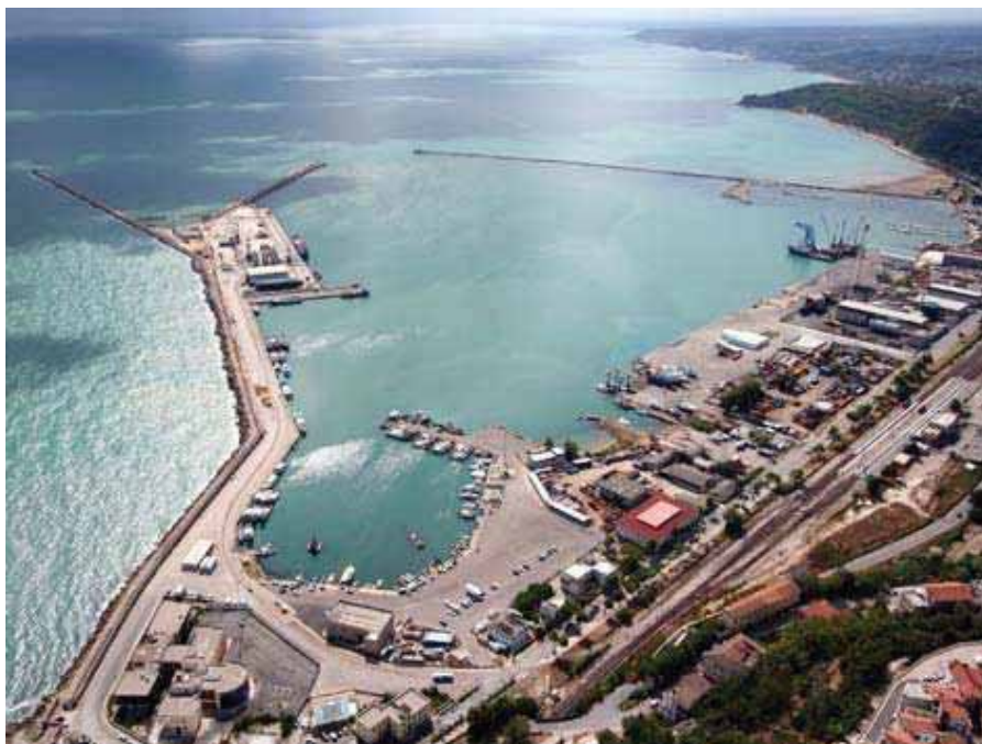
Particolare “area stoccaggio” trovanti da organizzare all’interno delle aree di cantiere
